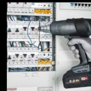
Kabel schrumpfen
